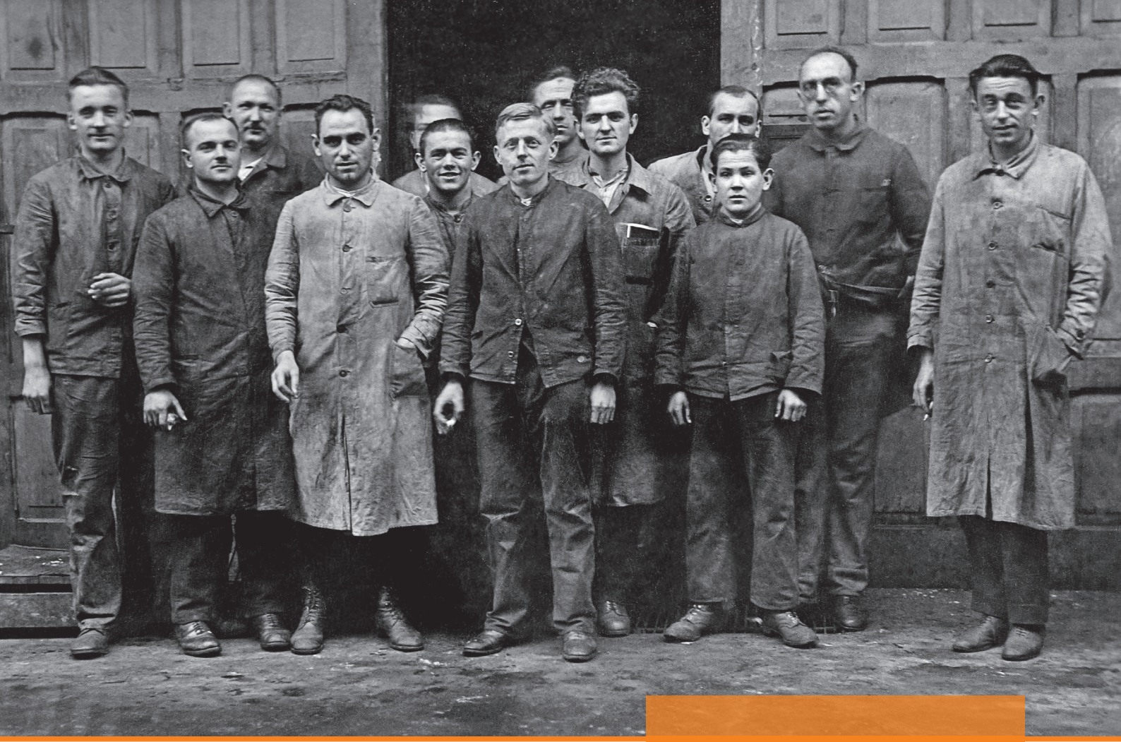
↑ Die Fabrikationsabteilung vor dem Gebäude Mündinger im Jahr 1928.
